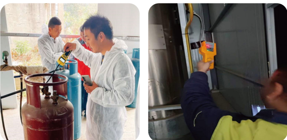
对消防器材和燃气进行专项检查
